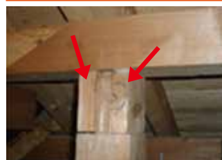
寸足らず材で付け足しをして施工
