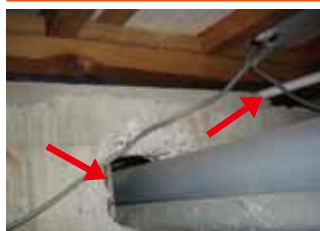
基礎をはつり、穴をあけて配管を通した
