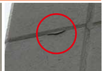
外壁材の割れ、欠損
